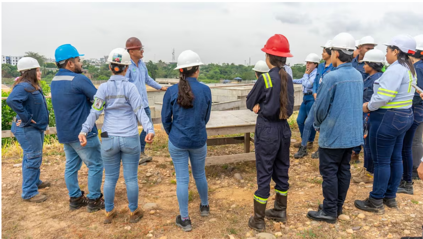
La PTAR San Silvestre continúa sin una reactivación efectiva de las obras, mientras Aguas de Barrancabermeja estudia la posible siniestralidad del contrato. Archivo/Suministrada/Vanguardia
