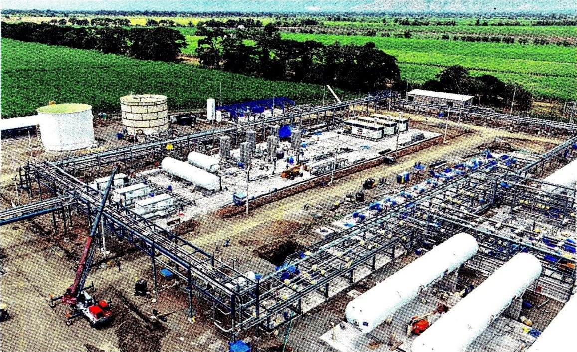
La Regasificadora del Pacífico es adelantada por la empresa Puertos Obras e Inversiones. PIO S.A.S.
