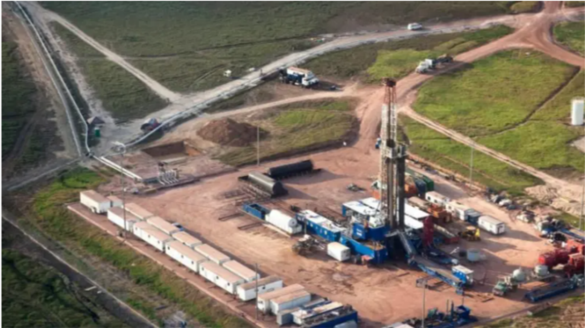
Ecopetrol operación en Caño Sur Foto:Archivo ET
