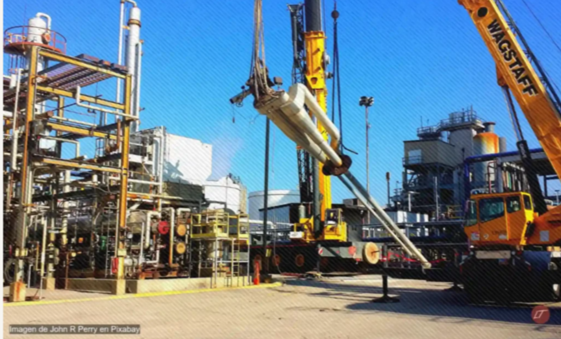
Grúa levanta tubería en una planta industrial. Foto: John R Perry, Pixabay.
