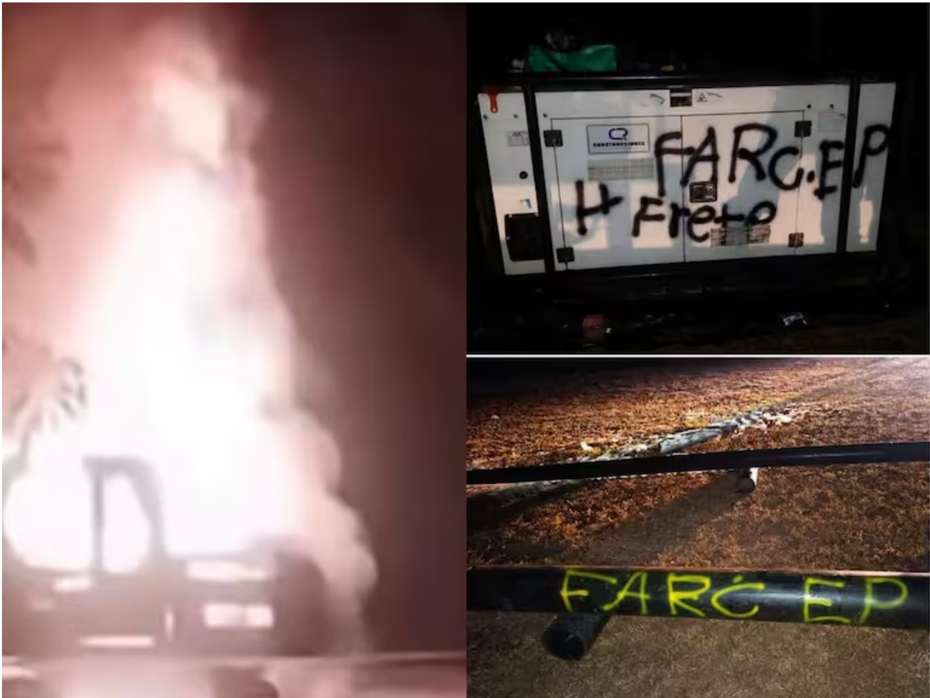
Disidencias Farc quemaron maquinaria de Ecopetrol en Yondó. Foto: Cortesía.
