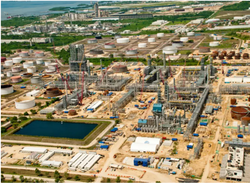
Refinería de Cartagena retomó operaciones normales tras superar una falla eléctrica sin afectar el suministro de combustibles. FOTO COLPRENSA.
