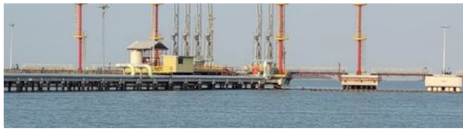
FOTO DE AERCHIVO: Complejo de tuberías utilizadas para la exportación de petróleo crudo en un muelle de la refinería Ecopetrol en Cartagena, Colombia 12 de abril 2024. REUTERS/Nelson Bocanegra
