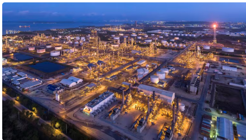
La refinería de Cartagena sufrió un daño el pasado 15 de marzo. Foto: Suministrado a SEMANA
