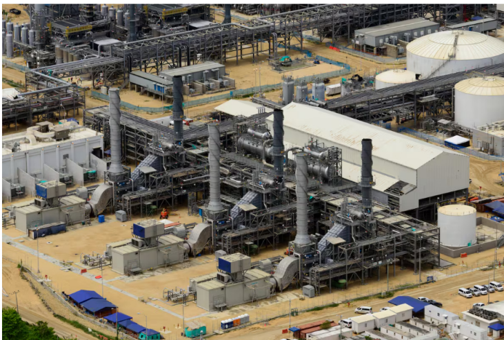
La planta de generación eléctrica de la Refinería de Cartagena. //Archivo El Universal.
