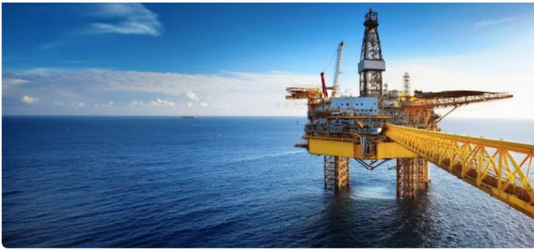
En el proyecto Sirius, en el Caribe, están las apuestas de que Colombia recupere la autosuficiencia en materia de gas. Foto: Ecopetrol
