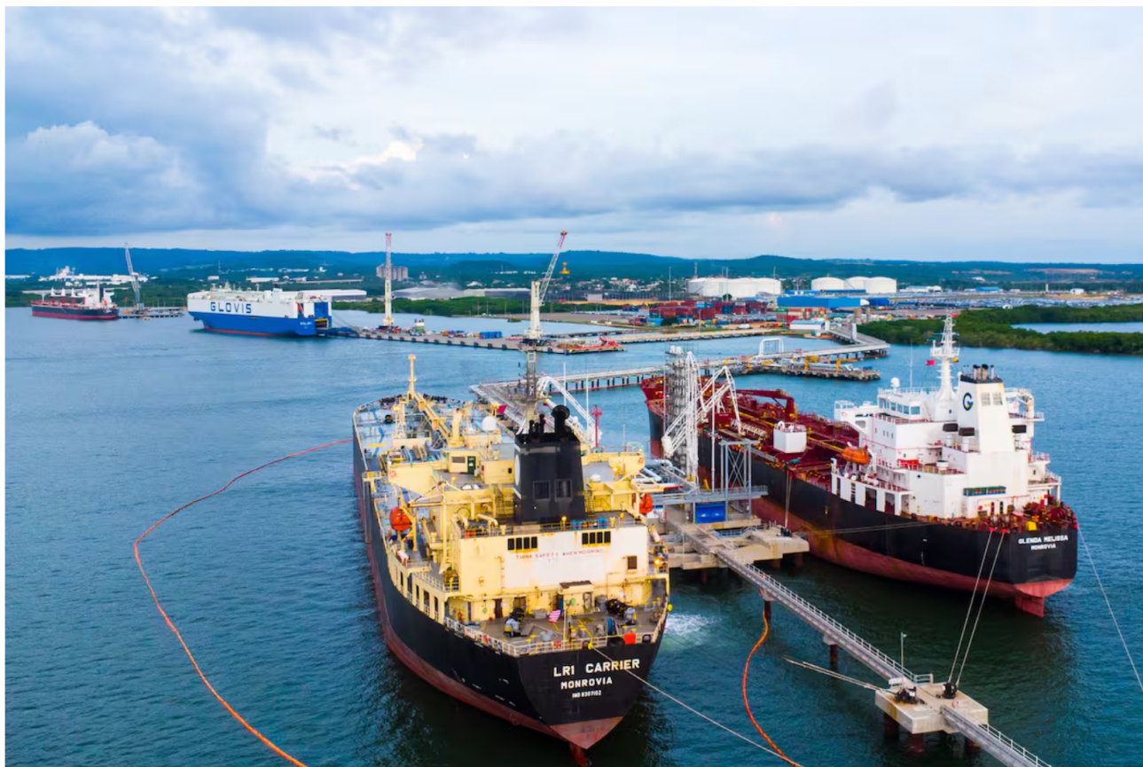
Dos tanqueros aparecen atracados en el muelle de líquidos de la Sociedad Portuaria Puerto Bahía, en Barú (Cartagena). // Foto Cortesía Ecopetrol
