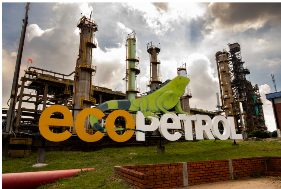
Letrero de Ecopetrol en la entrada de la planta de procesamiento de diésel en la refinería de Barrancabermeja, en Barrancabermeja.
