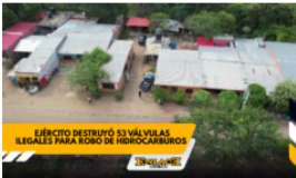
Ejército destruyó 53 válvulas ilegales para hurto de hidrocarburos
