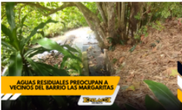
Aguas residuales afectan a familias del barrio Las Margaritas
