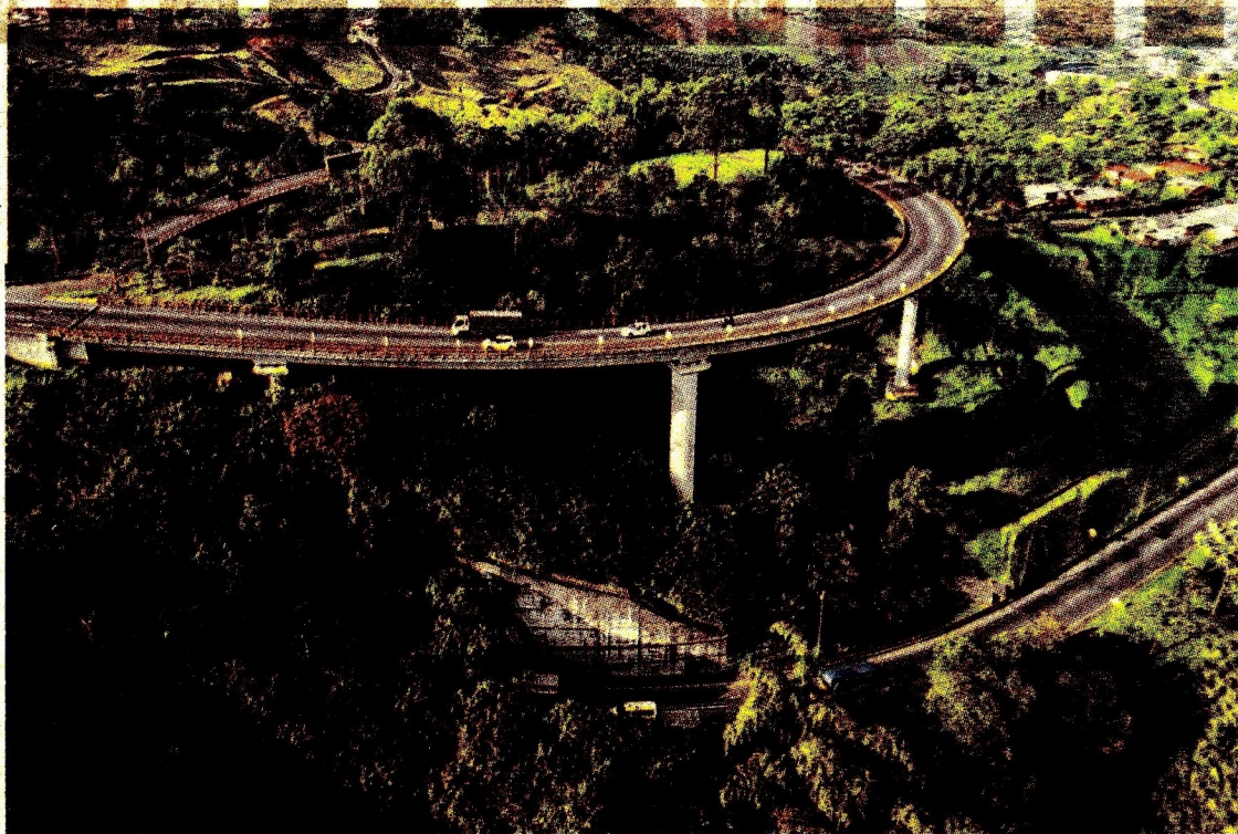
La concesión Autopistas del Café conecta a Caldas, Risaralda, Quindío y Valle del Cauca. Foto:Odinsa
