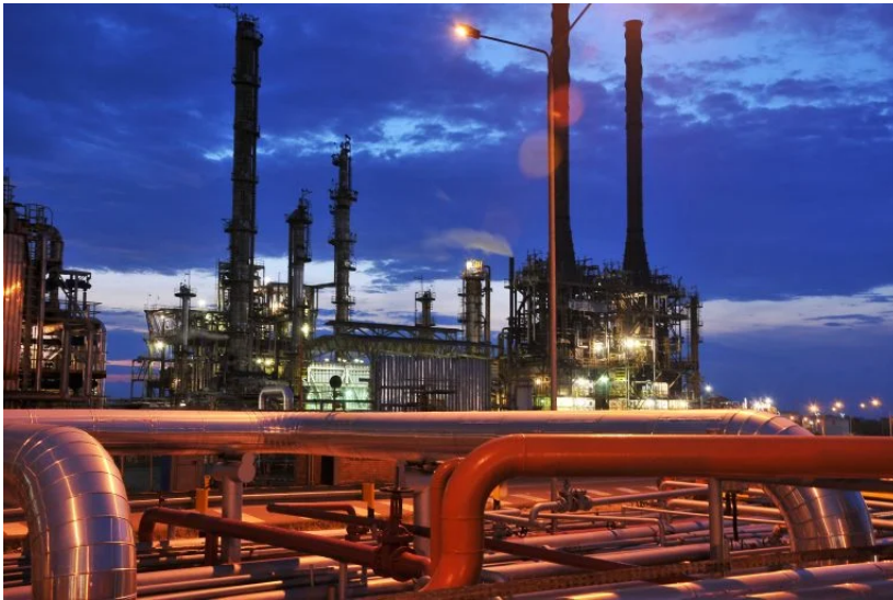
Foto: Ecopetrol. Refinería de Barrancabermeja.
