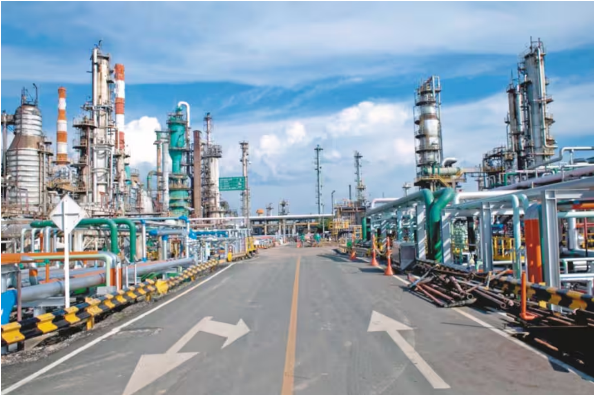
Refinería de Ecopetrol en Barrancabermeja.
