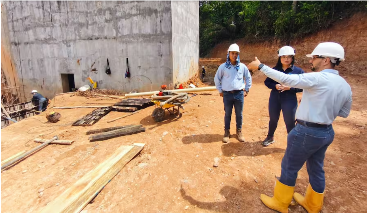
Los trabajos recientes en la Planta de Lodos se concentran en el conexionado de la red de media tensión hasta el pórtico, paso necesario para avanzar en la conexión eléctrica de la infraestructura. Suministrada/Vanguardia
