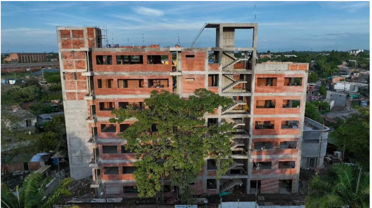
Nueva construcción de las UTS en el Puerto Petrolero.
