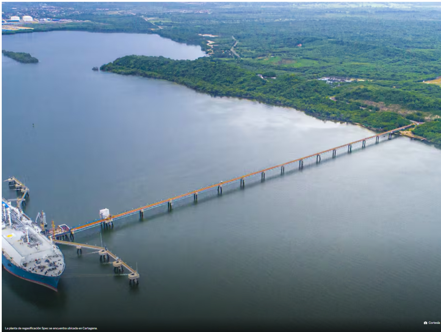
La planta de regasificación Spec se encuentra ubicada en Cartagena.
