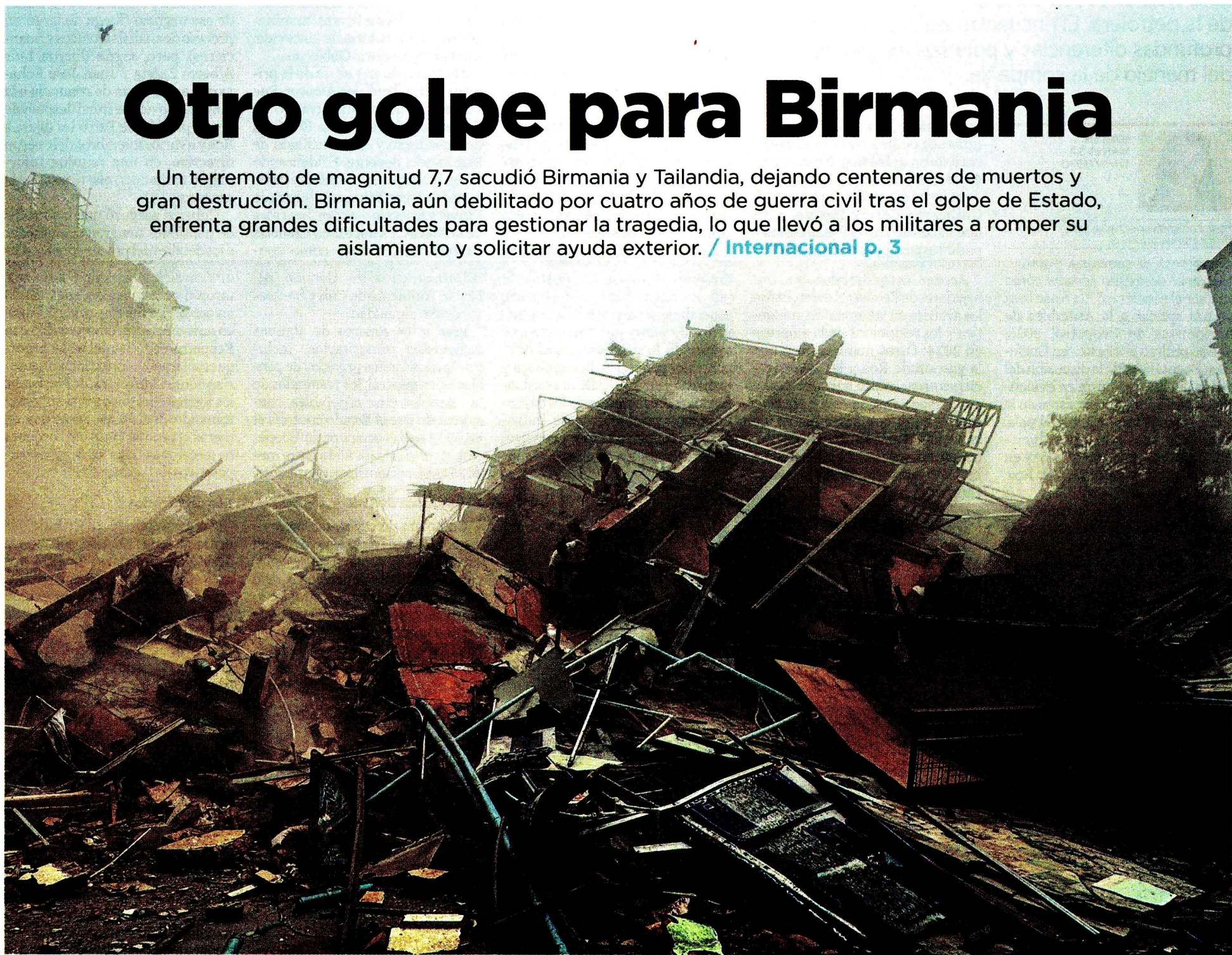
En Mandalay, Birmania, continúa la búsqueda de sobrevivientes del terremoto, que provocó el colapso de muchas edificaciones. Equipos inspeccionan las ruinas. / AFP
