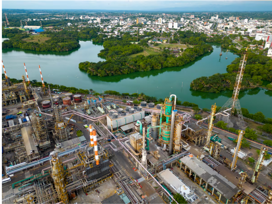
Refinería Barrancabermeja Ecopetrol, en Santander, Colombia. EIA
