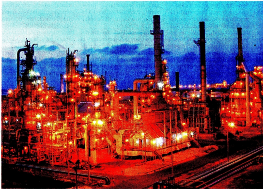
Ecopetrol se encuentra trabajando en la planeación y el diseño para sustituir la subestación de energía de Reficar. Se estima una inversión cercana a los 45 millones de dólares. FOTO: YONAHARA GRANDETTI, EL TIEMPO
