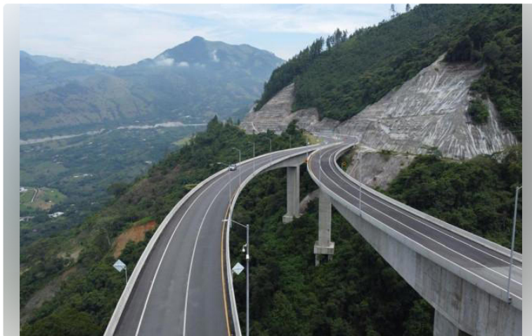
Unidad Funcional 2 Covipacífico © Covipacífico
