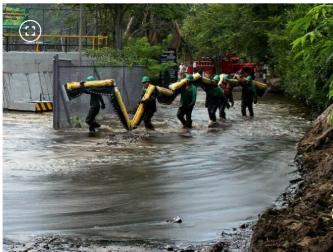
Trabajos de reparación al oleoducto Caño Limón-Coveñas. FOTO:ARCHIVO PARTICULAR
