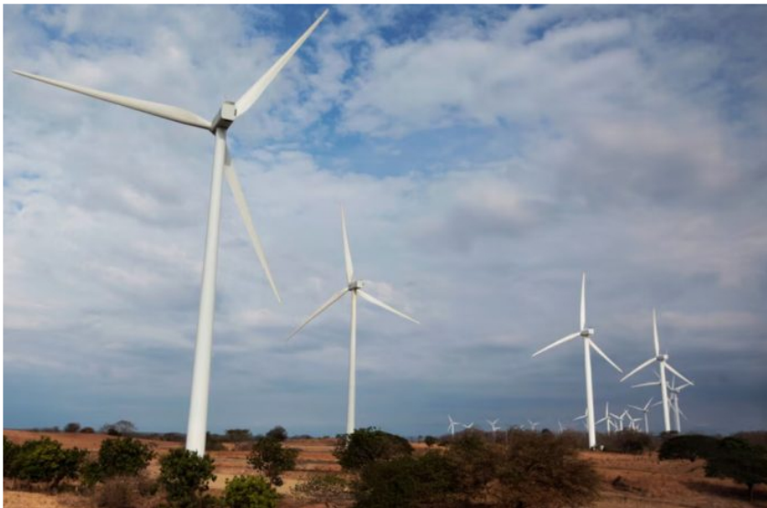
Vista de algunos aerogeneradores del parque eólico E200 en La Guajira. Foto: Mauricio Dueñas.
