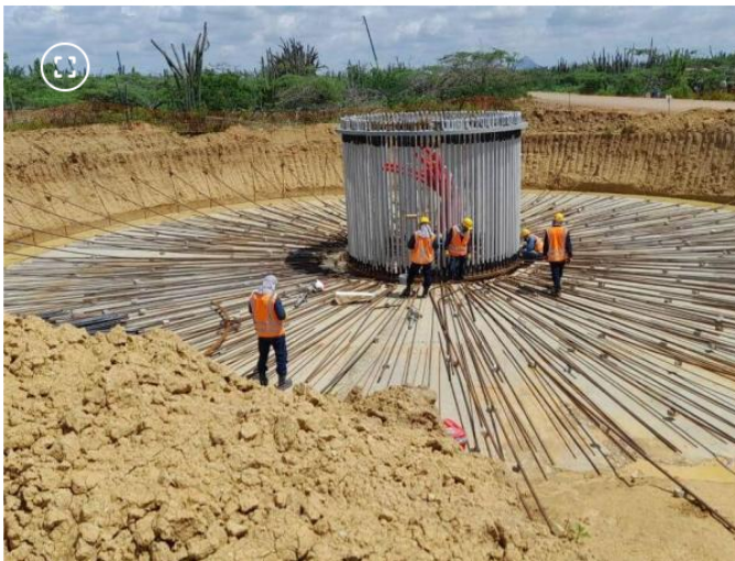
Obras en el parque eólico Windpeshi FOTO:ENEL COLOMBIA
