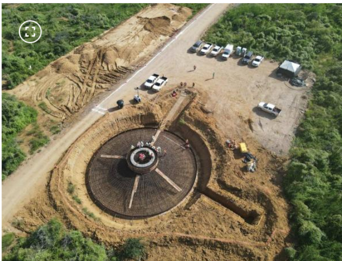
Obras en el parque eólico Windpeshi FOTO:FNFI GRFFN POWER
