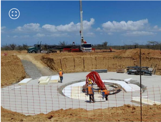
Obras en el parque eólico Windpeshi FOTO:ENEL GREEN POWER
