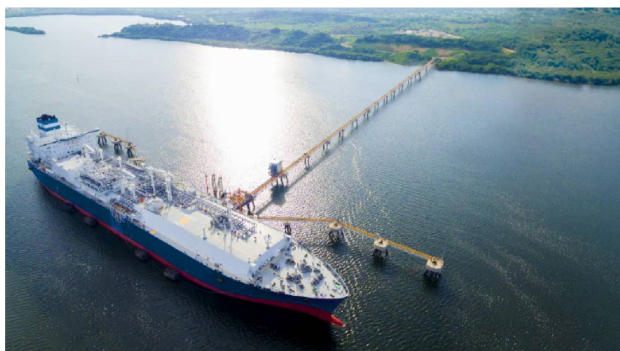
La planta de regasificación en el Caribe atiende básicamente las necesidades de los generadores térmicos. Sin embargo, tiene una capacidad adicional que le ha permitido importar gas para soportar la demanda en firme de algunas distribuidoras. | Foto: SPEC
