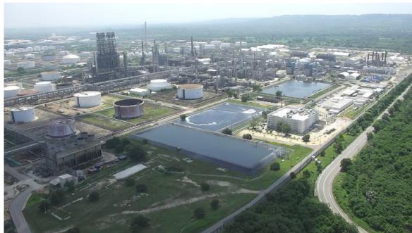
Vista panorámica de la Refinería de Cartagena. //Cortesia
