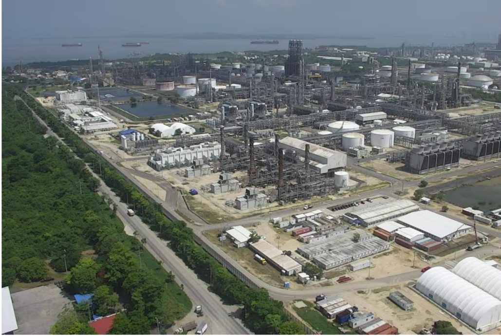
En primer plano las unidades de generación eléctrica de la Refinería de Cartagena. //Cortesia
