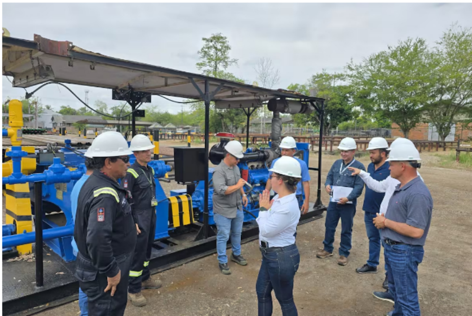
Una motobomba industrial, la 'clave' del nuevo proyecto de agua para Barichara
