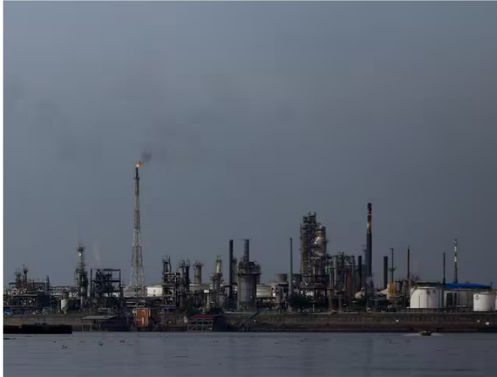
Refinería de Barrancabermeja. Foto: Colprensa(Colprensa)
