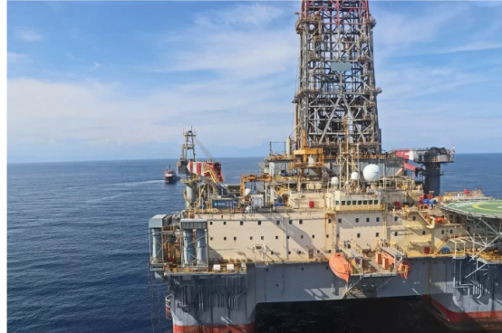
Pozo Sirius-2 de Ecopetrol y Petrobras // Foto: Ecopetrol.
