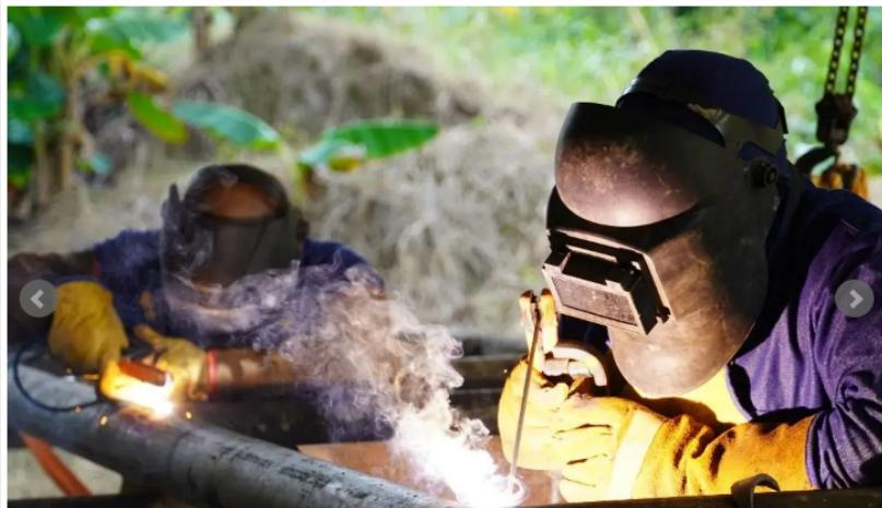
Puente: La tubería de perforación entregada por SierraCol Energy y Ecopetrol como insumo para la construcción de puentes, representa una solución innovadora, dentro de sus procesos de economía circular.
