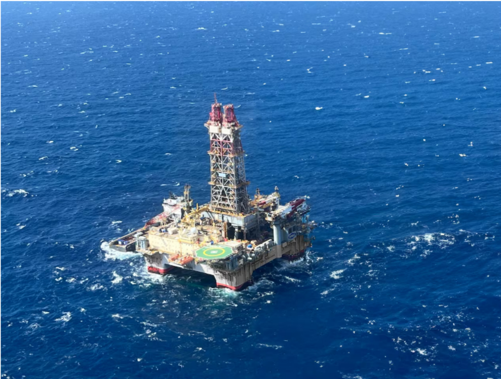
Plataforma de perforación de Uchuva 2 | Foto: Ecopetrol
