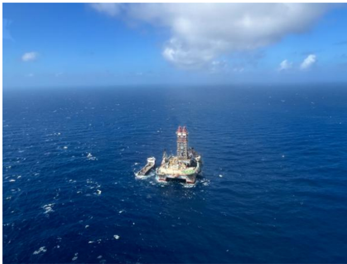
Plataforma de perforación de Uchuva 2 Ecopetrol
