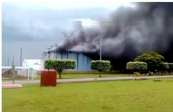
El denso humo que generó el incendio llegó a la zona urbana del municipio de Tauramena. Foto: archivo particular
