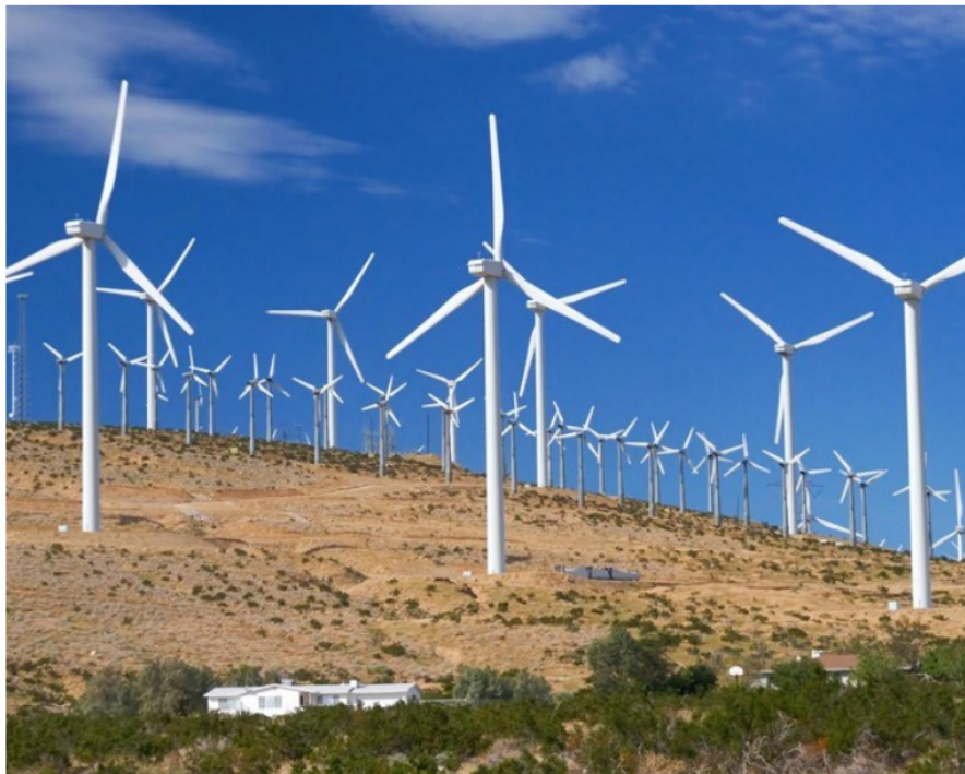
Foto referencia de parque eólico en La Guajira.
