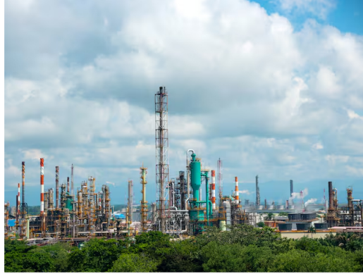
Refinería de Barrancabermeja, Colombia. Imagen vía Getty Images / EGT
