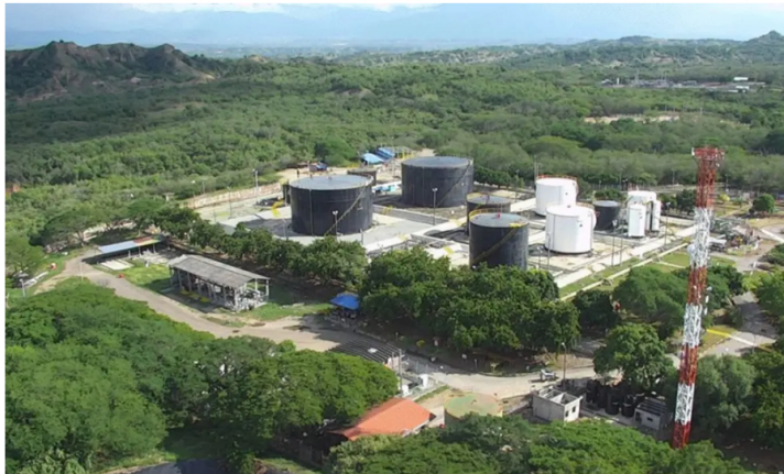
Planta de Ecopetrol. Foto: suministrada.
