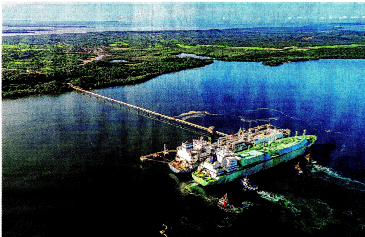
Desde abril, la planta de regasificación de Cartagena tiene una capacidad de 50 millones de pies cúbicos día (mpcd) adicional a los 400 mpcd que se usan para abastecer de gas natural a Tebsa, Termocandelaria y TermoFlores, y así generar energía eléctrica. FOTO: GALAMAU LING
