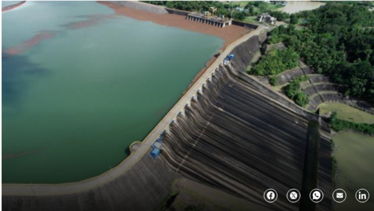
Electrificadora Urrá, en Córdoba.
