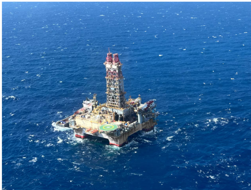
Plataforma de perforación de Uchuva 2 | Foto: Ecopetrol
