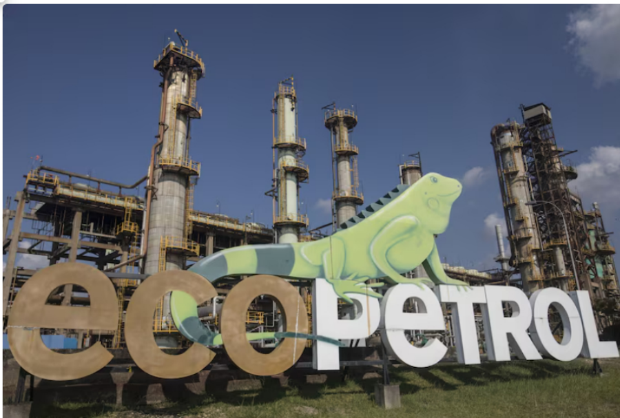
Ecopetrol y Promigas cierran acuerdo para garantizar abastecimiento de gas en Colombia Refinería de Ecopetrol en Barrancabermeja, Colombia. (Bloomberg/Ivan Valencia)
