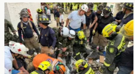
Desplome de edificio en Barranquilla deja una mujer sin vida
