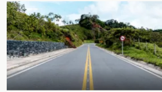
Contraloría alerta sobre graves irregularidades en infraestructura vial y obras públicas en el país
