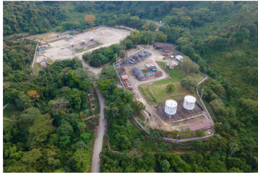
Ecopetrol alertó posibles restricciones de gas tras bloqueo a la planta de Gibraltar | Foto Suministrada
