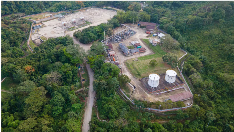
Vista de la planta de gas Gibraltar, de Ecopetrol | Foto: Cortesía / Ecopetrol
