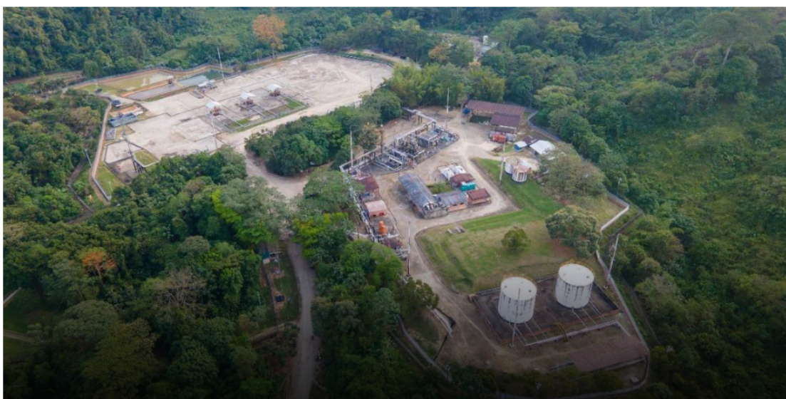
Planta de gas Gibraltar FOTO: Ecopetrol
