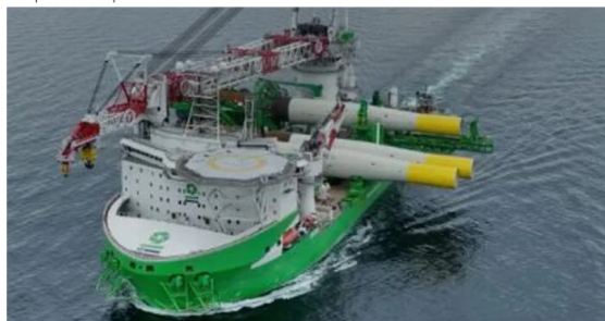
Construcción de aerogeneradores marinos por parte de Deme Group
