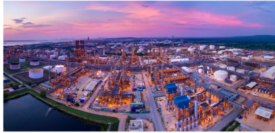
Toma aérea de Ecopetrol /Ecopetrol
