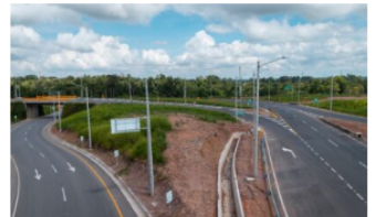
ACTUALIDAD / 5 días ago Ecopetrol adjudica contrato para culminar el sector 1 de la Gran Vía Yuma en Barrancabermeja
